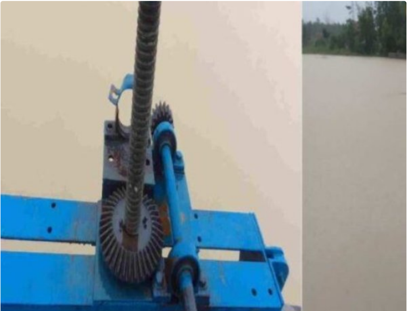
Pintu air Albaret Simpang Mesuji
